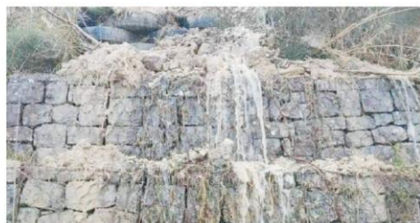
Polizzi Generosa. Una delle falle della condotta idrica
