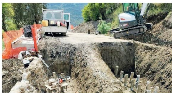
Madonie. L'intervento sulla strada statale 643 Polizzi-Scillato
