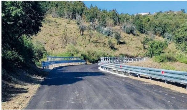
Riapertura. La strada statale 643 Polizzi-Scillato, dopo i lavori, torna transitabile. FOTO FALOB
